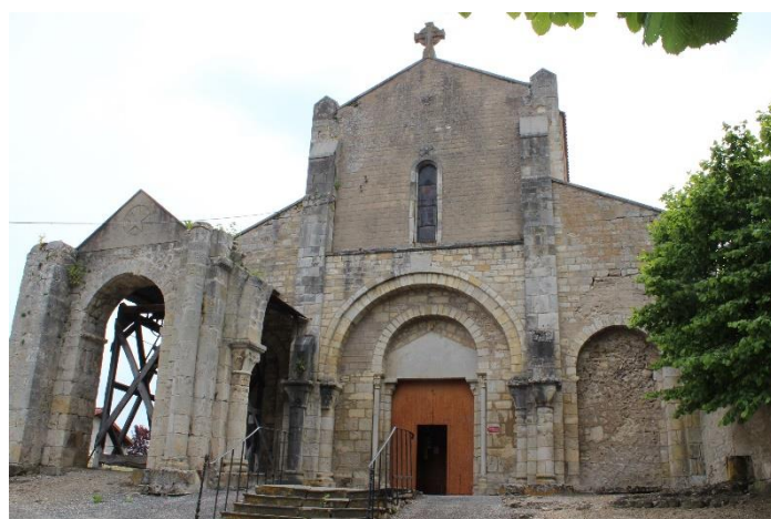
Le porche occidental et la façade.
